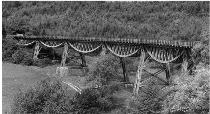
Biesenbach Viaduct, Blumberg Wutachtal Railroad, 1890 Eng. von Würthenau, Kräuter, Gebhard & Gernet
