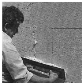
Abb. 2.4.4-2 Auftrag des Grundputzes von Hand
