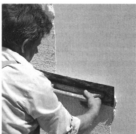
Abb. 2.4.4-3 Auftrag der Deckschicht
