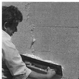
Abb. 2.4.4-2 Auftrag des Grundputzes von Hand
