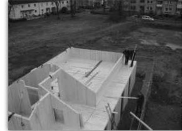
Beginn des Ausbaus 1. EG
