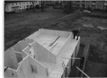
Beginn des Ausbaus 1. EG
