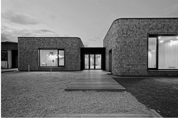
Kindergarten Josef-Felderstr. 29, Augsburg Architektur: Hiendl & Partner Architekten, Passau
