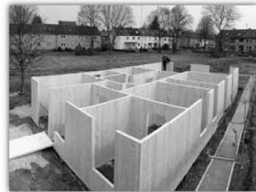
Alle Wände im EG stehen
