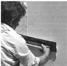
Abb. 2.4.4-3 Auftrag der Deckschicht
