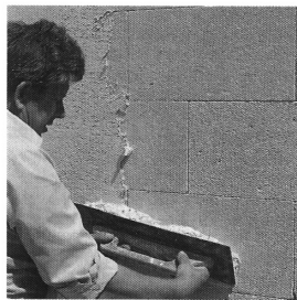
Abb. 2.4.4-2 Auftrag des Grundputzes von Hand
