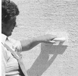
Abb. 2.4.4-4 Verreiben der Putzoberfläche mit Filzbrett oder Schwammscheibe
