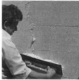
Abb. 2.4.4-2 Auftrag des Grundputzes von Hand
