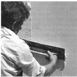
Abb. 2.4.4-3 Auftrag der Deckschicht
