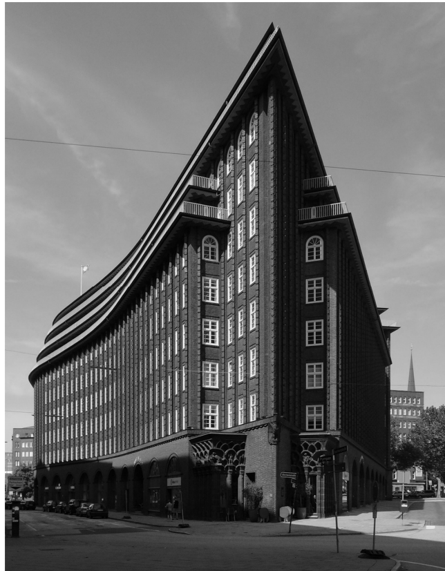
Chilehaus, Hamburg Arch: Fritz Höger, 1924
