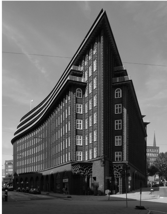
Chilehaus, Hamburg Arch: Fritz Höger, 1924
