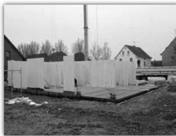
Die ersten Seitenteile stehen
