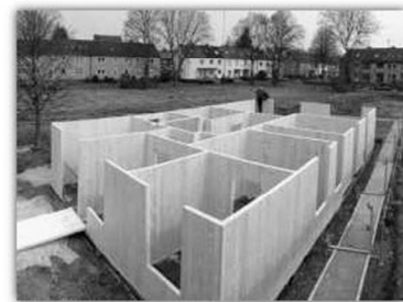
Alle Wände im EG stehen
