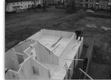
Beginn des Ausbaus 1. EG
