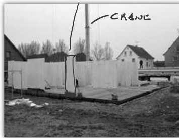
Die ersten Seitenteile stehen
