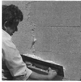
Abb. 2.4.4-2 Auftrag des Grundputzes von Hand
