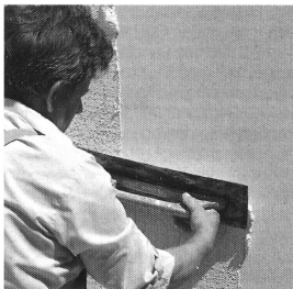
Abb. 2.4.4-3 Auftrag der Deckschicht
