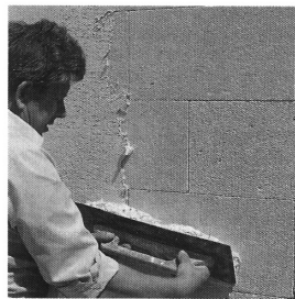
Abb. 2.4.4-2 Auftrag des Grundputzes von Hand
