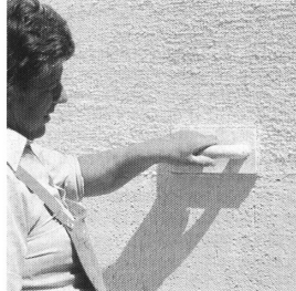
Abb. 2.4.4-4 Verreiben der Putzoberfläche mit Filzbrett oder Schwammscheibe
