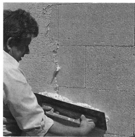
Abb. 2.4.4-2 Auftrag des Grundputzes von Hand
