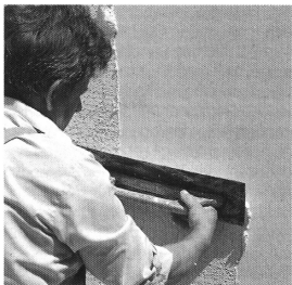
Abb. 2.4.4-3 Auftrag der Deckschicht
