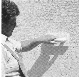
Abb. 2.4.4-4 Verreiben der Putzoberfläche mit Filzbrett oder Schwammscheibe
