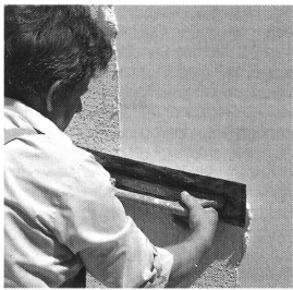
Abb. 2.4.4-3 Auftrag der Deckschicht
