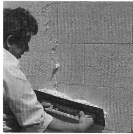
Abb. 2.4.4-2 Auftrag des Grundputzes von Hand
