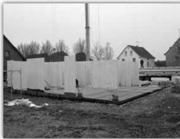
Die ersten Seitenteile stehen
