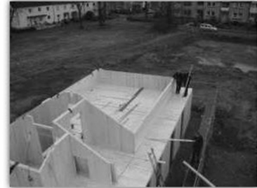
Beginn des Ausbaus 1. EG
