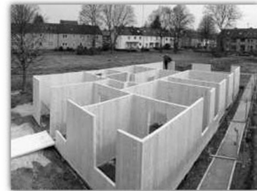
Alle Wände im EG stehen
