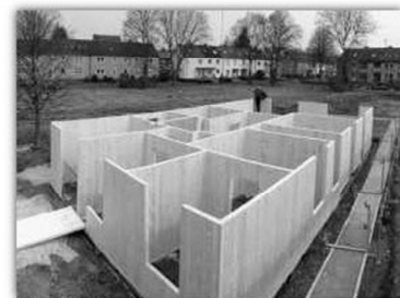
Alle Wände im EG stehen
