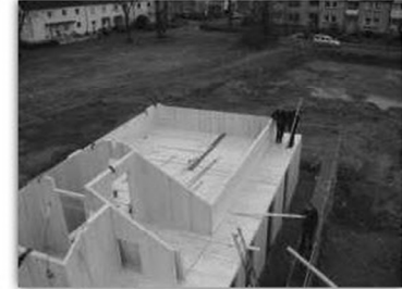
Beginn des Ausbaus 1. EG
