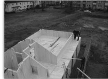
Beginn des Ausbaus 1. EG
