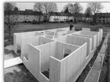
Alle Wände im EG stehen
